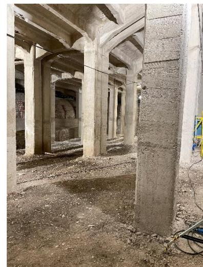
Gli interventi riguardano il ripristino delle condizioni originarie delle strutture in cemento armato, con particolare attenzione ai fenomeni di degrado rilevati sul materiale, al fine di assicurare un miglioramento
